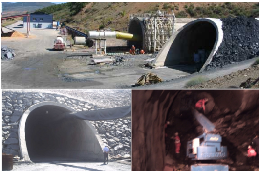
Figure 13: Tunnels in Fundación Santa Bárbara, at Bembibre (León)
