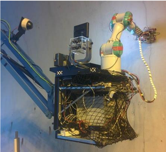
Figura 7. Herramienta de inspección con Sensor de Ultrasonidos midiendo una grieta detectada en un túnel.
